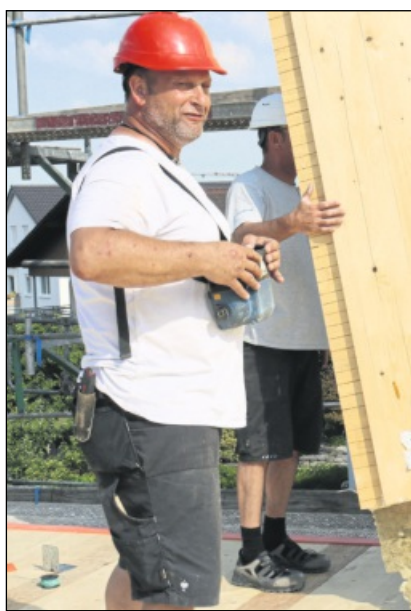
IN DER PRALLEN SONNE arbeitet Andreas Link. Er installiert Fertigbaudecken. Fotos: Lothar/Waidelich
